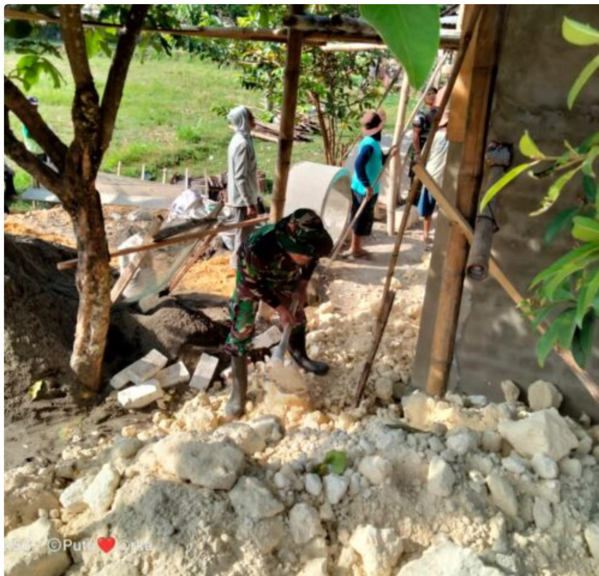
Montong Kodim 0811 Tuban bersama warga melaksanakan karya bakti pembangunan Mushola Mamba'ul Hikmah di Desa Nguluhan Kecamatan Montong Kabupaten Tuban, Sabtu (03/09/2022).
